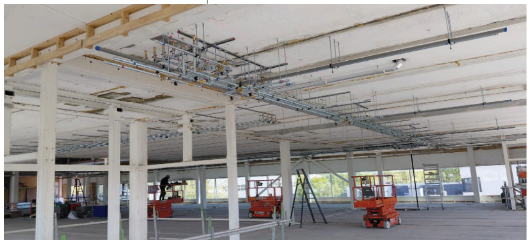
Foto 2: De installatietechniek kon niet zo maar worden 'meegenomen'. De installatie is niet geoptimaliseerd rond hergebruik, maar rond de nieuwe functionele vraag.
