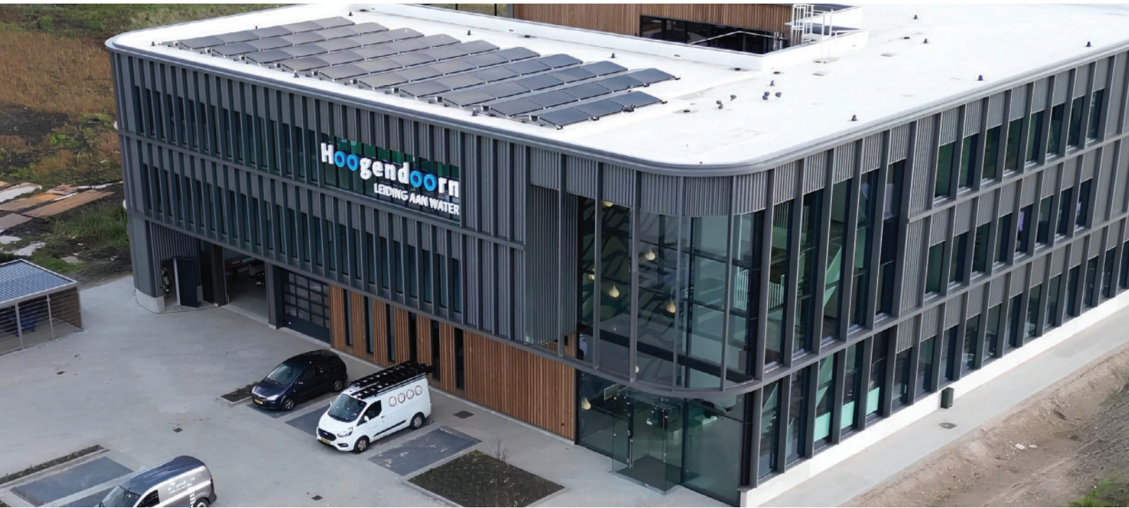
Foto 1. Het nieuwe bedrijfspand van Sanitair Installatie Hoogendoorn langs de A12 in Woerden is strak vormgegeven. Het pand is modern en duurzaam gebouwd, dankzij een goed geïsoleerde gevel, een wit dak, zonnepanelen, warmtepompen en een daktuin.
