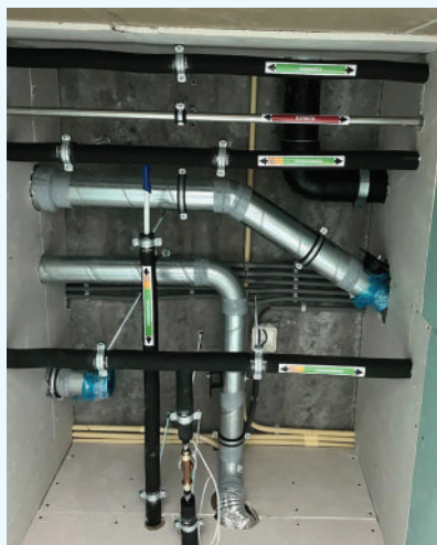
Foto 2, 3, 4. In het pand zijn niet één, maar vijf afzonderlijke waterleidingsystemen aangebracht.
