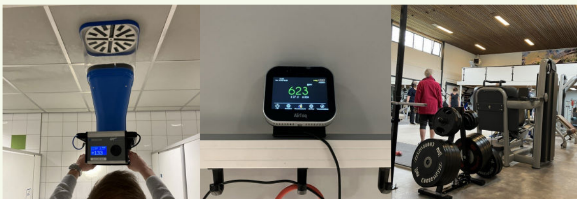
Foto 1. Controlemeting van luchthoeveelheden uit roosters.
