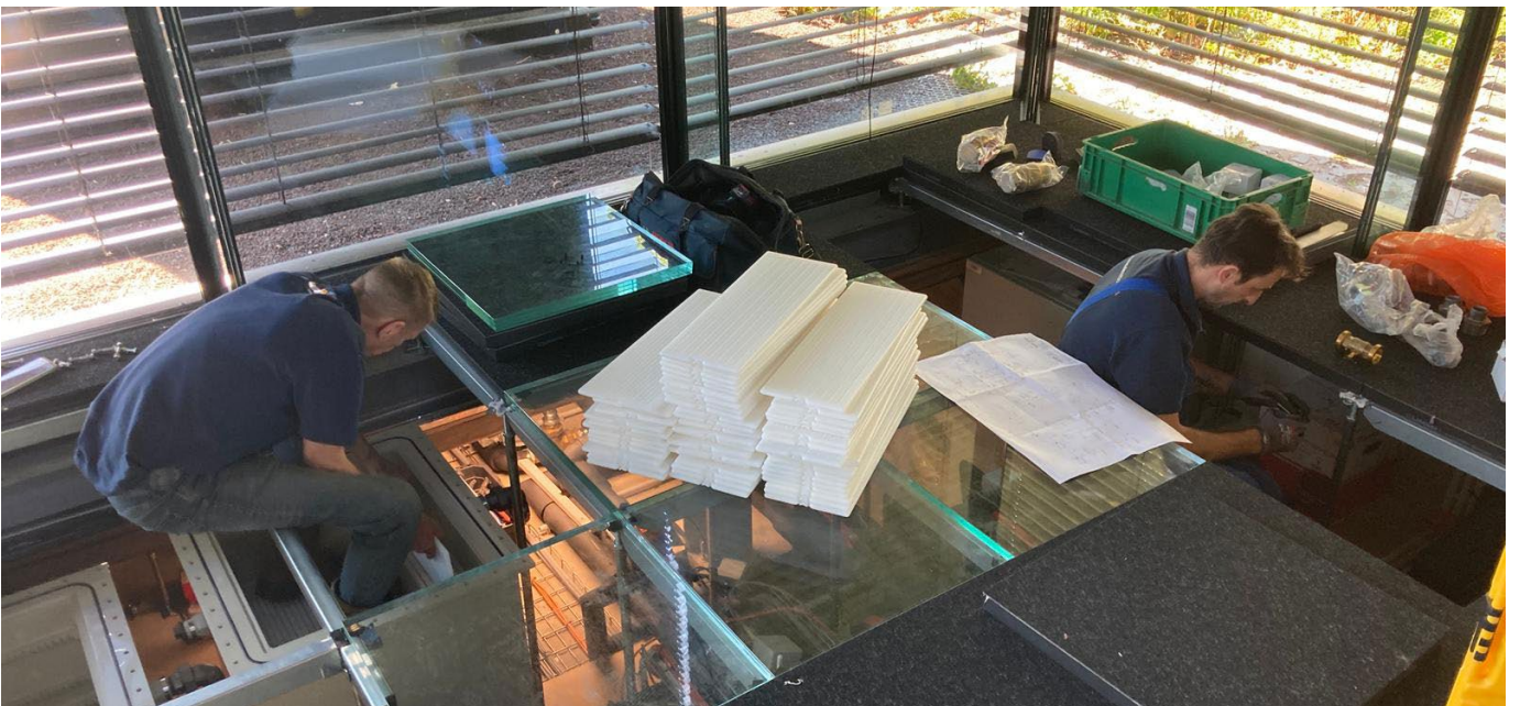
Foto's 2-4: Weergave modulaire PCM-buffers. De buffers bij Orange Climate (a, b). Plaatsing van de buffers onder de vloer (c).
