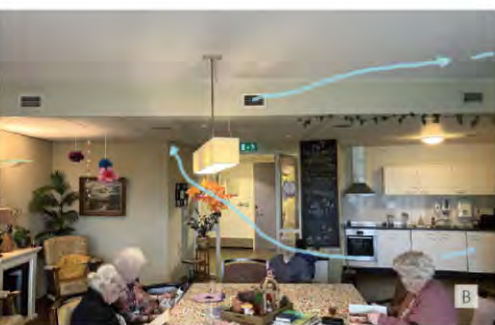
Tocht door hoge inblaasluftsnelheid vanuit roosters in koef en luchtcirculatie.
