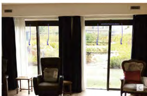
Tocht vanuit ventilatieroosters in kozijnen boven de stoelen van bewoners.
