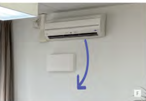
Koude luchttoevoer uit airco zorgt voor tochtklachten.
