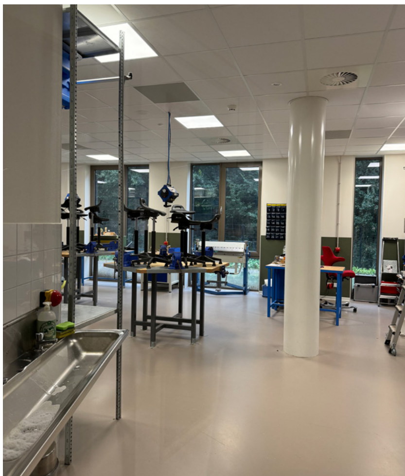
Foto 9: In de BINASK-lokalen – voor de beta-vakken – kunnen uit het plafond contactdozen worden getrokken in plaats van het realiseren van veel wandcontactdozen.
