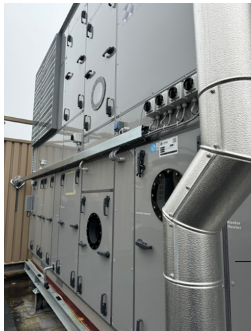
Foto 3a + 3b: Ook staan de luchtbehandelingskasten van de school en de sporthal op het dak.
