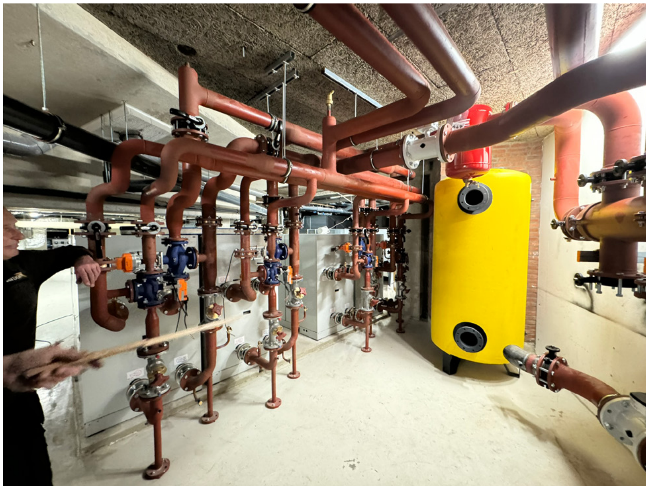
Foto 5: Het water uit de riothermiebron moet nog verder worden opgewaardeerd, waarvoor vier grote waterwaterwarmtepompen worden gebruikt. Foto: Van Dorp.
