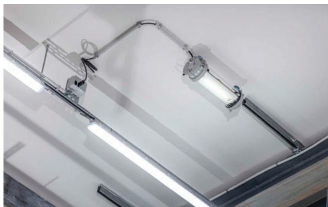
Foto 4 en 5: Alle installaties zijn zichtbaar, wat niet alleen een industrieel karakter oplevert, maar ook onderhoud vergemakkelijkt.
