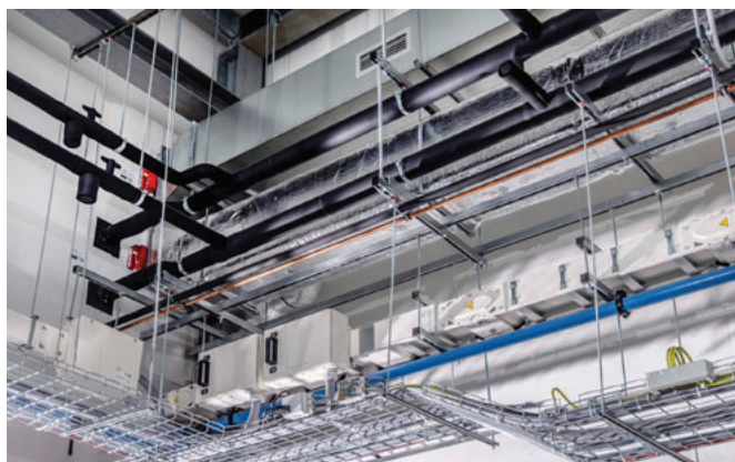
Foto 4 en 5: Alle installaties zijn zichtbaar, wat niet alleen een industrieel karakter oplevert, maar ook onderhoud vergemakkelijkt.
