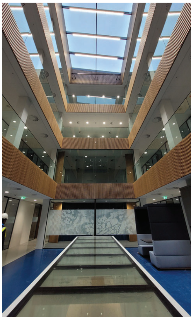
Foto 3: Bij het ontwerp is veel aandacht besteedt aan daglichttoetreding. Zo is de middenbeuk van het gebouw een groot atrium waar veel licht binnenkomt.
