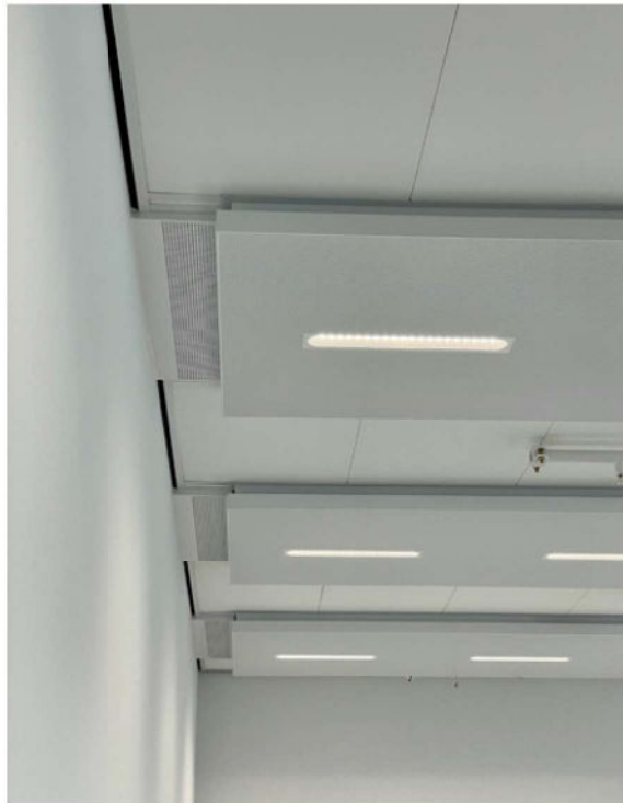
Foto 3: Voor luchtverversing in de onderwijsruimten is gekozen voor zogeheten hybride 'klimaat-eilanden'; een soort klimaatplafond waar de lucht door wordt verspreid. Die 'eilanden' hangen modulair in alle ruimten.
