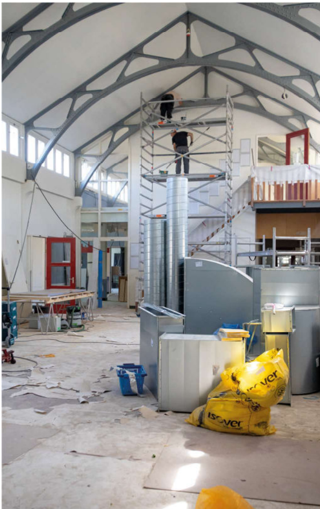
Foto 4 en 5: De aanpak van de twee vleugels met de leslokalen had prioriteit. Daar was het binnenklimaat het slechtst, omdat er nog geen luchtbehandeling in deze vleugels was.
