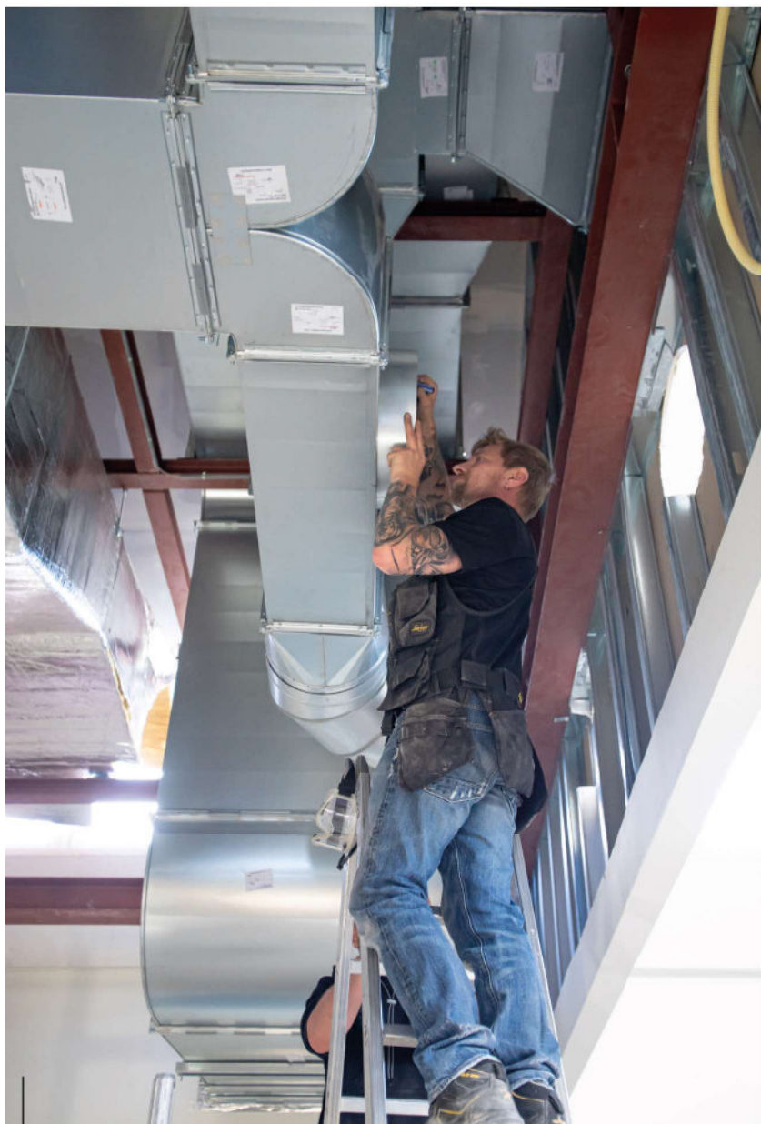
Foto 3: Het aanleggen van het ventilatiesysteem was in dit project de grootste uitdaging. Grote ventilatiekanalen door de klaslokalen waren daarbij nodig.
