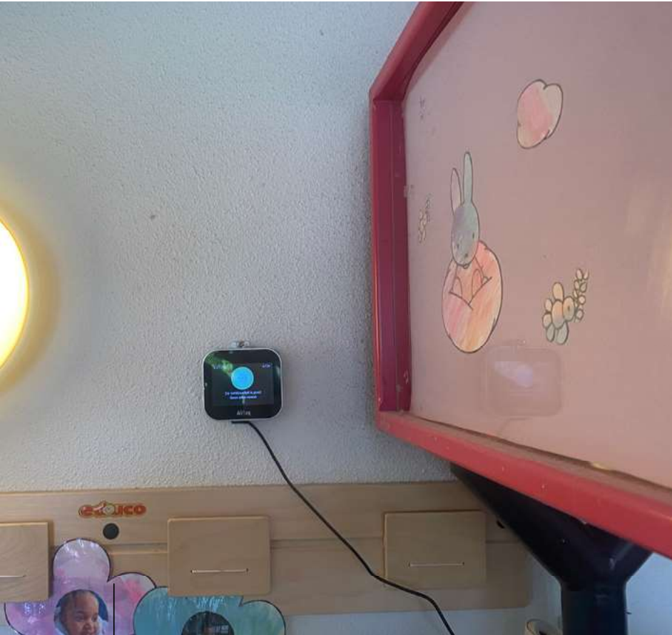
Foto 1: In de kinderdagverblijven van Humankind worden sensoren van Airteq gebruikt om de luchtkwaliteit te meten. Op displays is door de medewerkers zelfs te lezen of er actie gewenst is.
