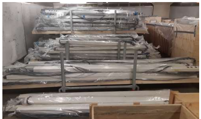
Foto 2 + 3 + 4: Uit het kantoorgebouw zijn meerdere installatieonderdelen verzameld en bewaard voor hergebruik.
