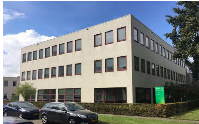
Foto 1: Eén van de kantoorgebouwen in Bunnik.
