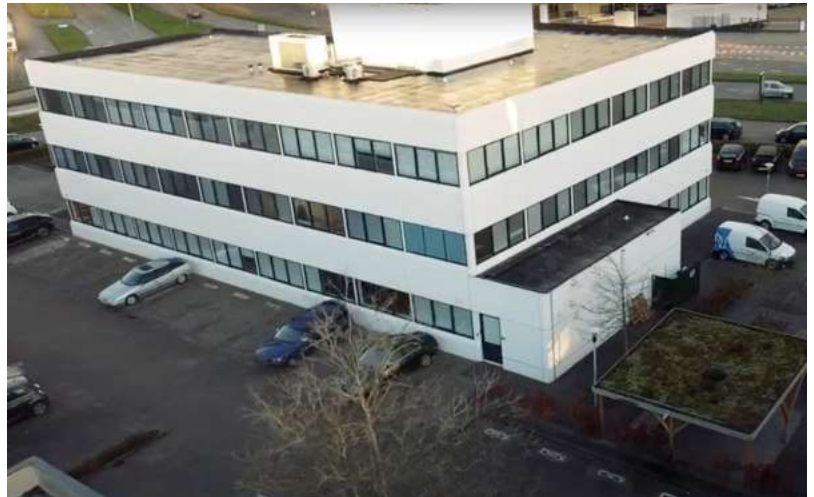
Foto 1: Voor het pand van Nieman in Utrecht is het werkelijke energiegebruik uitgerekend. Volgens de redactieraad van TVVL Magazine gaat het WEii van een gebouw gaat het bestaansrecht van dat pand aantonen.
