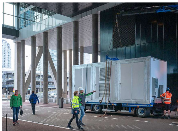
Foto's 1a-c: De plaatsing van de stadsbatterij bij Rijnstraat 8 in Den Haag. © Rijksvastgoedbedrijf, foto Bas Kijzers.
