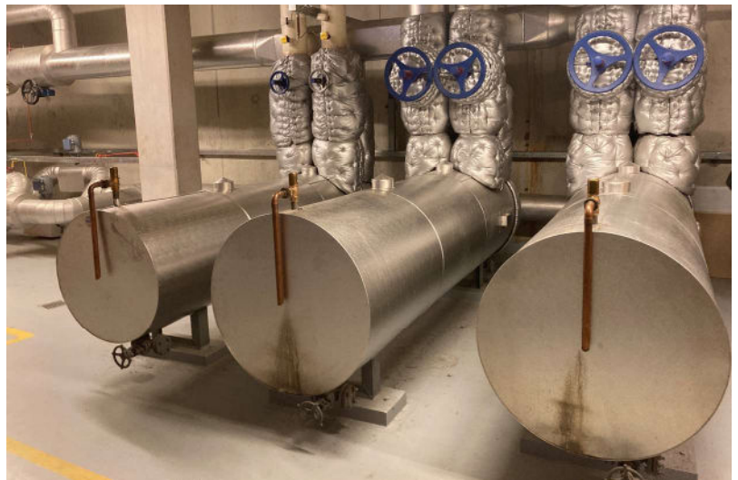
Foto 2: Warmtewisselaar van het Stadhuis. ERDH heeft in samenwerking met de gemeente Den Haag en Eneco een geslaagde temperatuurverlagingstest uitgevoerd op de stadswarmte-aansluiting van Stadhuis Den Haag.
