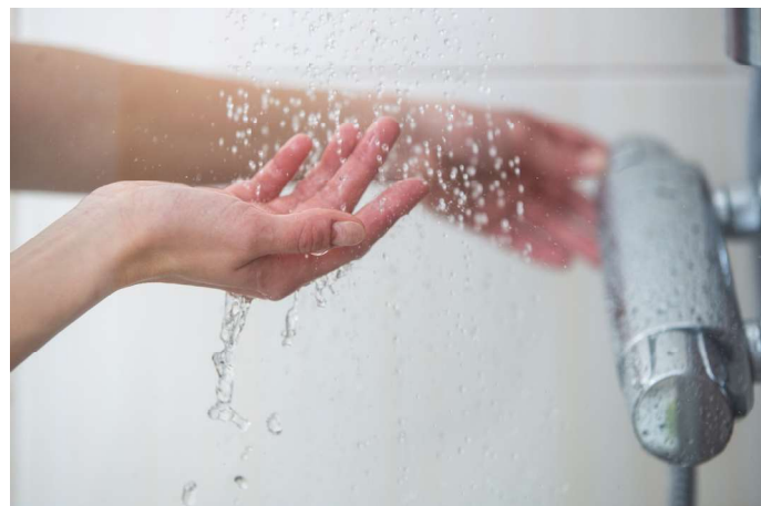
Foto 1 en 2: Wisselende mengwatertemperaturen hebben altijd een fluctuerende druk als oorzaak.
