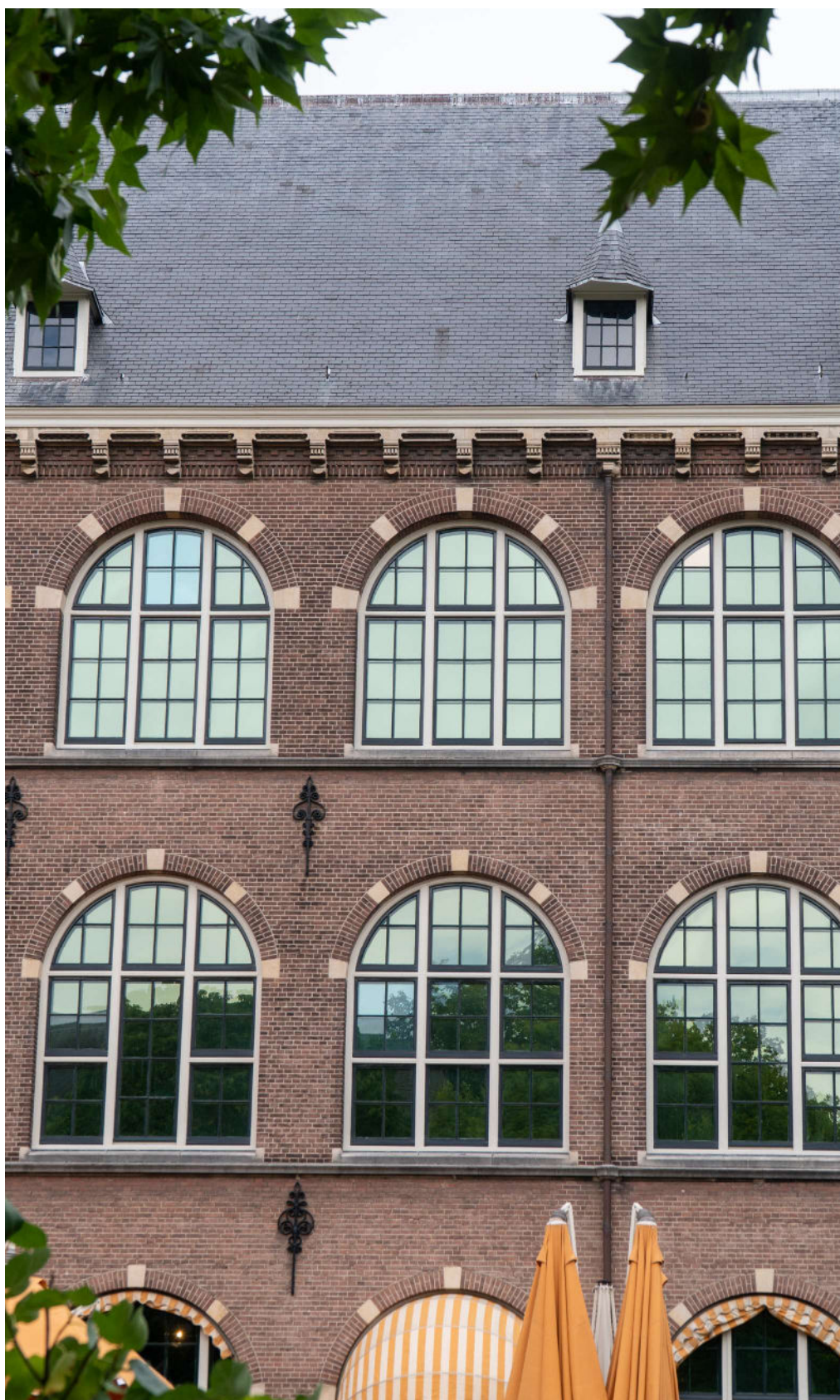
Foto 7: De binneninstallatie van het museum is aangepast om met de iets lagere temperaturen om te kunnen gaan. Daarnaast zijn er honderden voorzetzamen geplaatst in het monument. Vervolgens is er een test gedaan en bleek dat de cv-installatie op 60 graden kon draaien.
