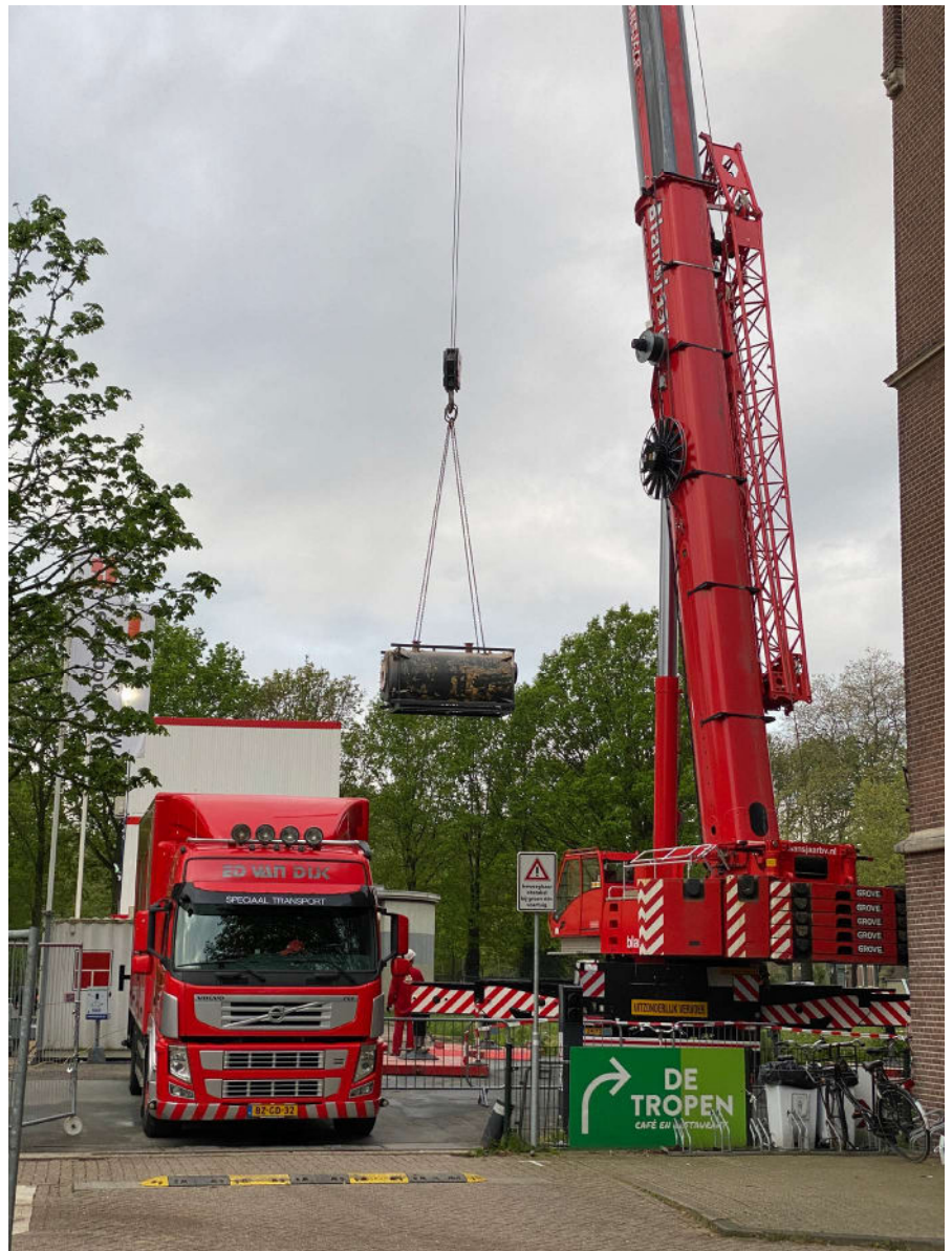
Foto 4 tot en met 6: De oude ketels zijn uit het museum gehesen en afgevoerd.
