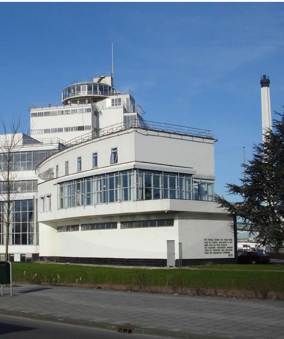
Foto 1: De voormalige Van Nellefabriek aan de Delfshavense Schie in Rotterdam geldt als het voornaamste industriële monument in Nederland. Het is nu in gebruik als eventlocatie. Foto: Wikipedia/F.Eveleens
