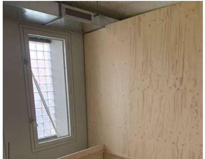
Foto 2: Het hotel en de hostel zijn bereikbaar via de zij-ingang. In het hostel-deel worden de kamers opgedeeld door middel van afscheidingen die van boven open zijn. Op de beide hostelverdiepingen is voor de ventilatie een soort ringleiding geïnstalleerd, die de kamers van frisse lucht voorziet.
