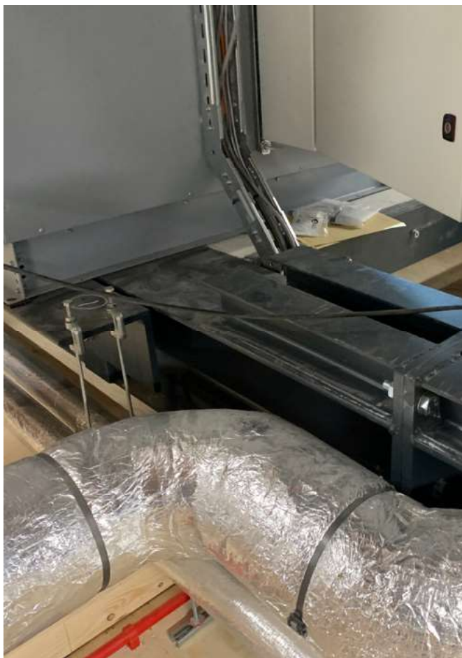
Foto 9: Voor de luchtbehandeling van de Statenzaal en het daaronder gelegen grand-café is op de zolder een luchtbehandelingskast gerealiseerd. Om die te kunnen dragen in het oude pand is een speciale stalen balkenconstructie gemaakt.
