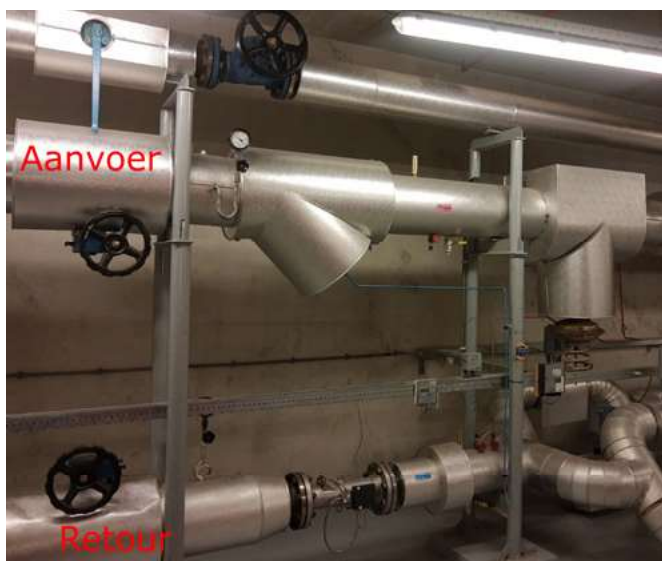
Foto 3: De 2 x 2 kleppen die zorgen voor aanvoer en retour van warm water in het systeem.
