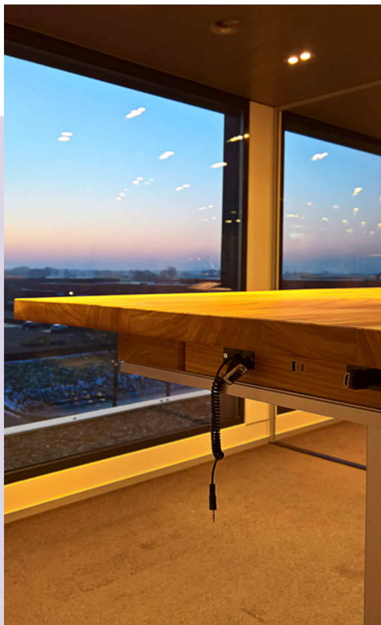
Foto 3: Een vergadertafel uit 2016 waarin zowel beeld, internet als voeding zijn geïntegreerd in één aansluiting, een modernere versie van de USB aansluiting: USB type C. Deze vergadertafel werkt zowel op gelijkspanning (DC) als op wisselspanning (AC). Bron: Tafel gemaakt door Houtwerk-Hatterm
