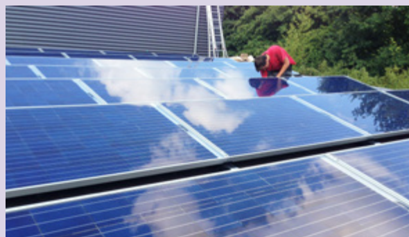
Foto 2: Foto Zonnepanelen produceren gelijkspanning.
