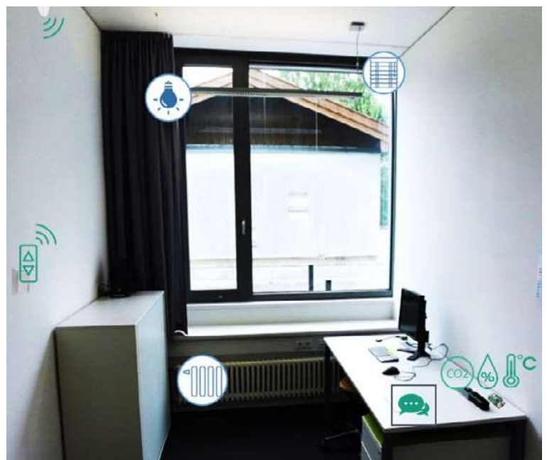
Figuur 2: Een kamer met binnenklimaat bewakingsapparatuur.
