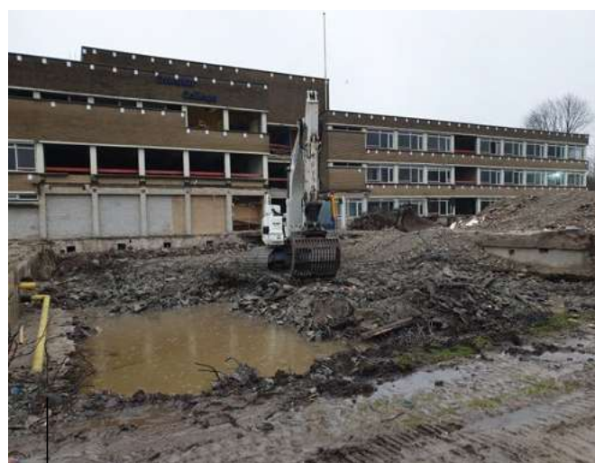
Foto 2: Het hogere bouwdeel is gerenoveerd, de aula heeft plaatsgemaakt voor nieuwbouw.
