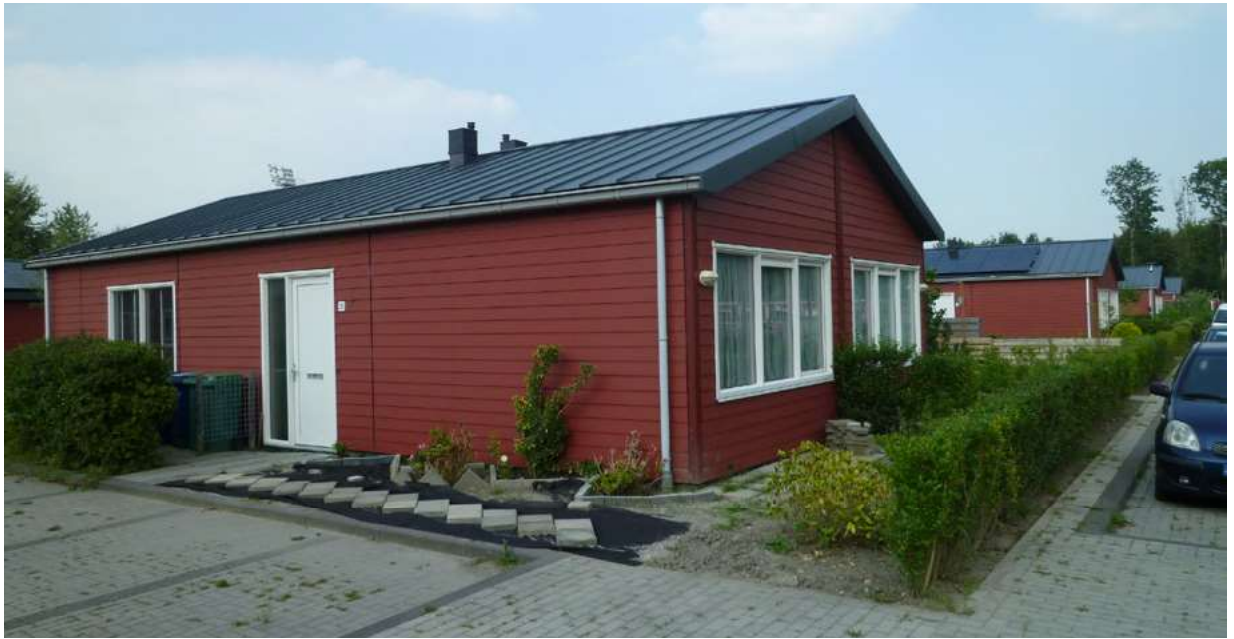
Foto 1: Voorbeeld houtskeldebouwwoning met oververhittingsklachten.
