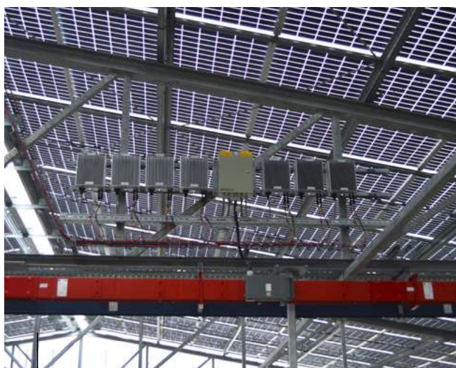
Foto 4: Optimisers van FerroAmp brengen de gelijkstroom die afkomstig is van de pv-panelen naar een spanningsniveau van 760 V.
