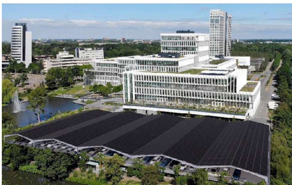
Foto 5: Het van 2013 tot 2015 gerenoveerde kantoor van asr in Utrecht. Deze oorspronkelijk uit de jaren '70 afkomstige kantoorcomplex, is met een gebruik van 48 kWh/m 2 /j nu Paris Proof.
