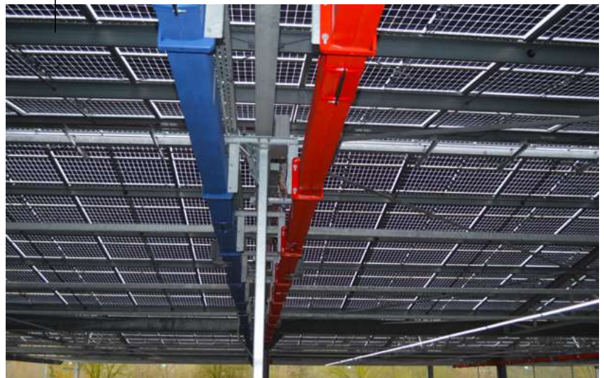
Foto 3: De rode railkokers zijn voor DC, de blauwe voor AC. Via een aftakkast op de rail, kan een laadpaal worden aangesloten.
