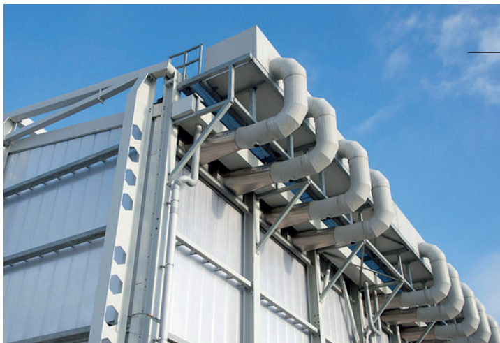
Foto 5: Voor Jungola is een klimaatsysteem ontworpen dat zijn lucht via nozzles met hoge snelheid hoog in de kas langs het dak inblaast en laag in de kas afzuigt.
