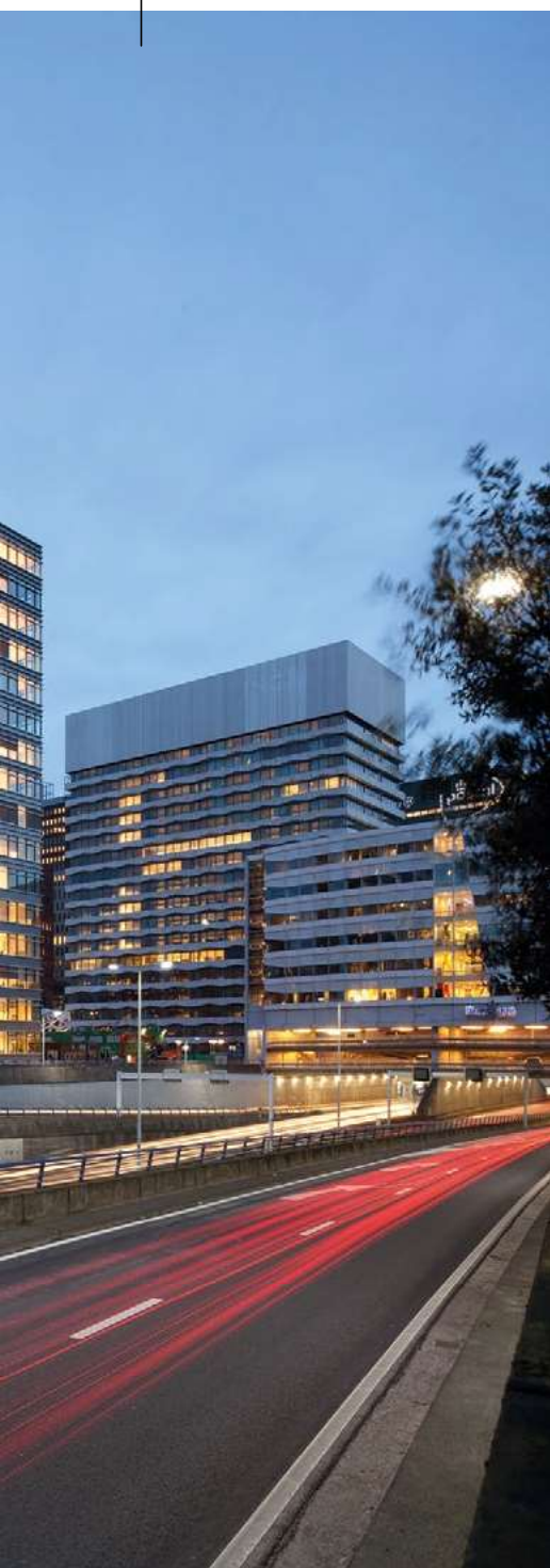
Figuur 1: In het gebouw De Monarch in Den Haag zijn alle technische installaties in de ruimte nauwkeurig te regelen via een op KNX-gebaseerd systeem.
