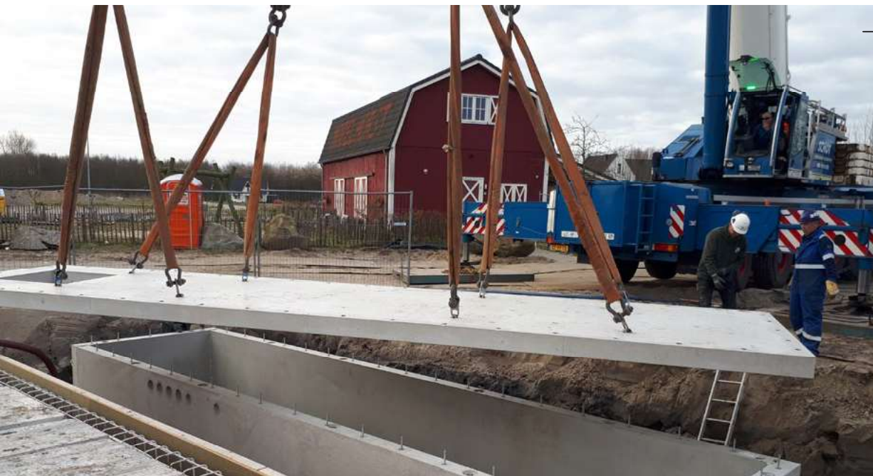
Foto 4: De warmtepomp werkt met een interessante bron, want in plaats van een reguliere bronboring, is er hier gekozen voor een 60 kuubs ijsbuffer van het bedrijf Solareis.
