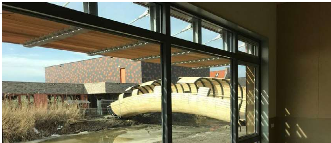
Foto 2: Oversteken boven de ramen laten winterzon binnen maar weren de hete zomerstralen.
