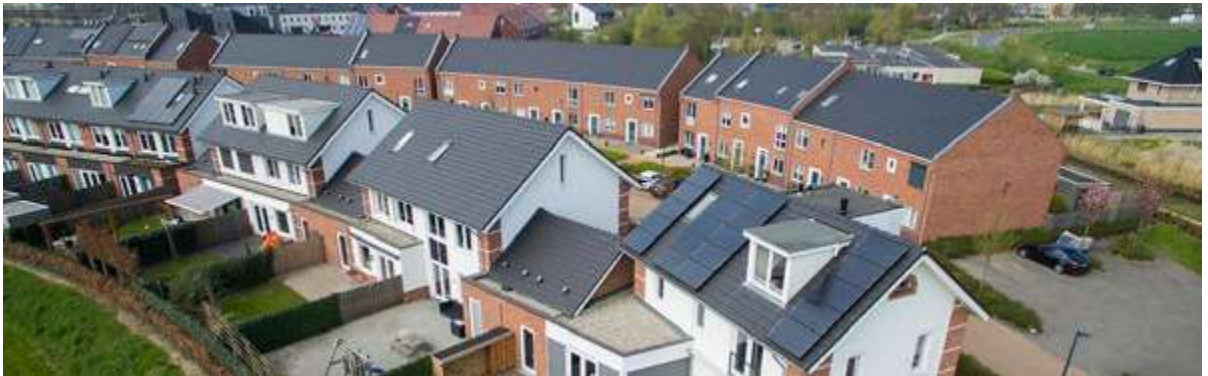
Foto 3: Stedin heeft in Gorinchem een dergelijk slim systeem opgezet, dat de verbinding vormt tussen zonnepanelen en een thuisbatterij.
