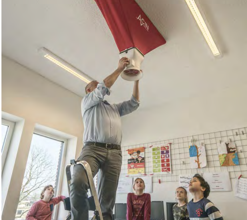
Uitvoeren van debietmetingen in een klaslokaal.
