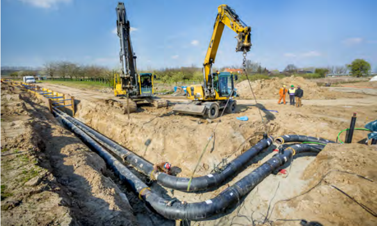
Aanleg van een warmtenet
