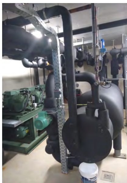
-Figuur 5- In Urk wordt warmte gewonnen uit een nabij gelegen rioolpersleiding van het waterschap middels riothermie
