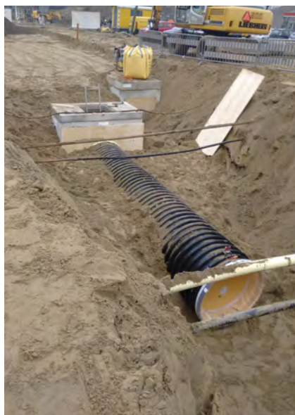
-Figuur 4- Aanleg riolering voorzien van een geïntegreerde warmtewisselaar
