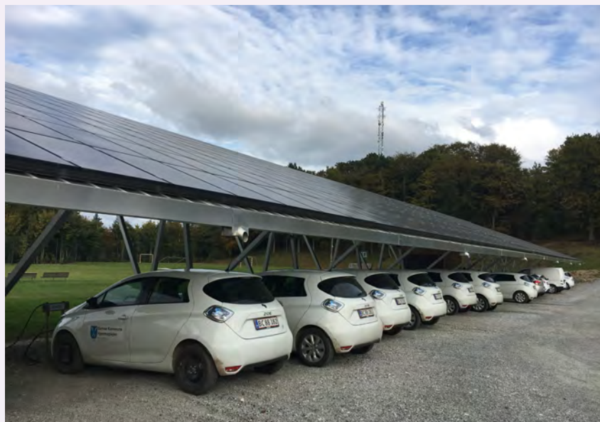
Pv-panelen voor het opladen van elektrische auto's
