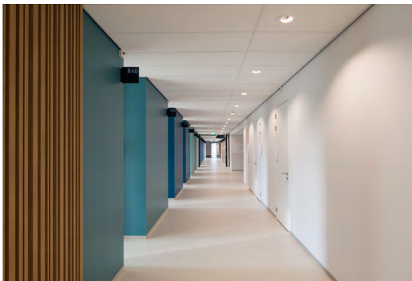
De ledverlichting in de gangen is asymmetrisch aangebracht, zodat patiënten die in bedden worden vervoerd niet constant in het felle licht hoeven te kijken.
