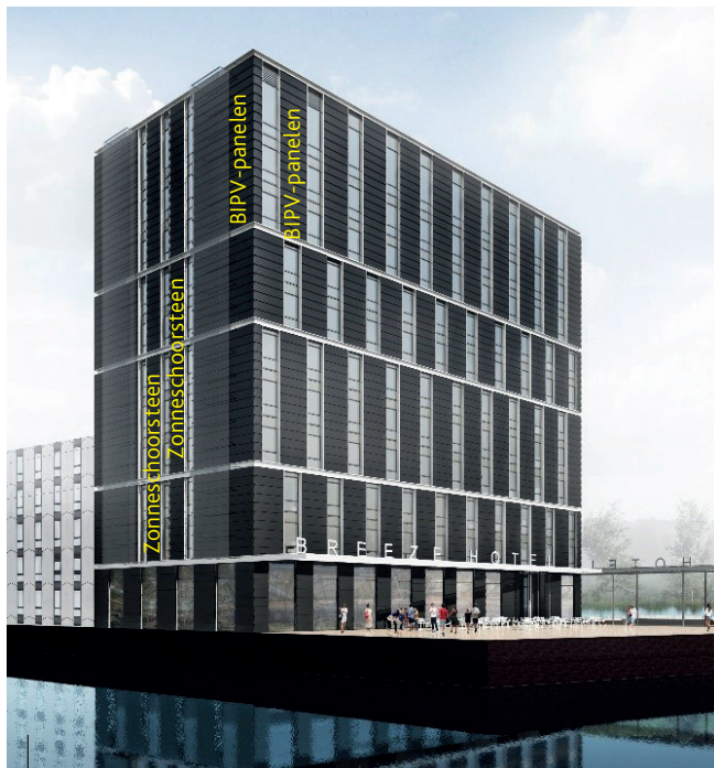
Figuur 3: De tweeling-zonneschoorsteen OZ Architecten.
