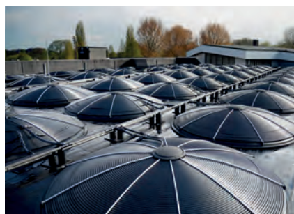
Het zwembad heeft een energiedak met bolcollectoren
