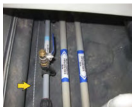
-Figuur 5- Deze leidingen zijn beveiligd met waterdetectie-koord
