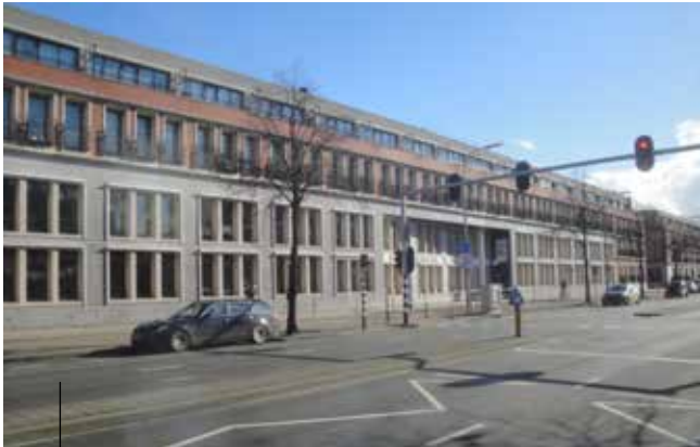
Foto 1: School op een verkeersbelaste locatie. De lokalen aan de straatzijde zijn voorzien van mechanische luchttoevoer, waardoor lucht gefilterd kan worden. De buitenlucht wordt aangezogen aan de verkeersluwe achterzijde van het gebouw. Ramen aan de straatzijde kunnen niet worden geopend.
