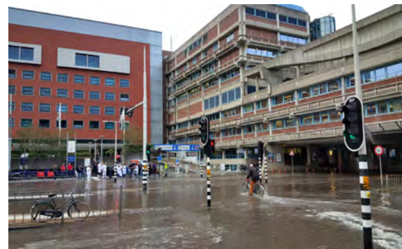
-Figuur 5- Het VUmc in Amsterdam werd vorig jaar september platgelegd door een gesprongen waterleiding. Het water stroomde naar het ketelhuis in de kelder en bereikte ook de elektronica van de liften (foto: Sharon Dijksma)
