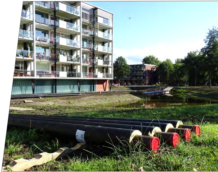
Het appartementencomplex wordt aangesloten op het warmtenetwerk
