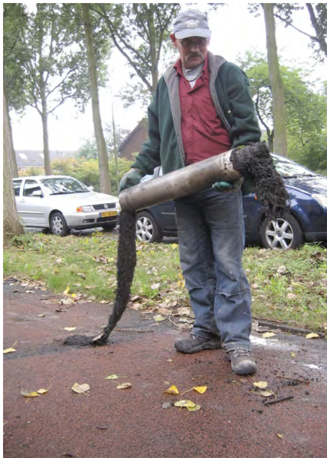
-Figuur 3- 'Paardenstaart' in PVC riolering
