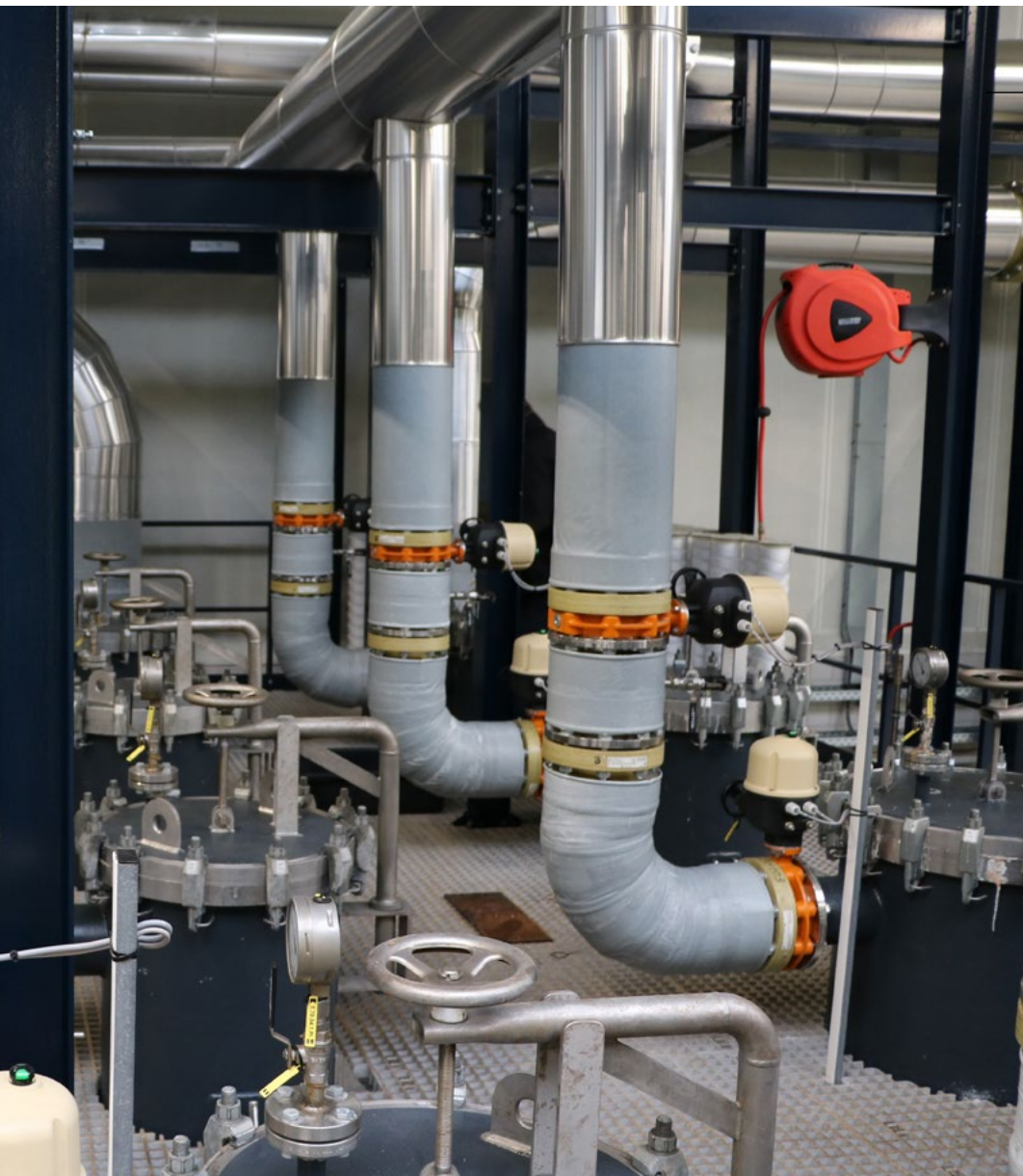
Foto 2: Filterinstallatie Geothermie
