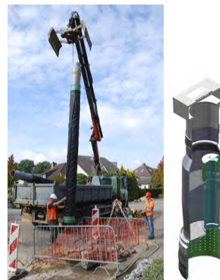
-Figuur 4- De realisatie van een verticaal infiltratiesysteem te Landgraaf
