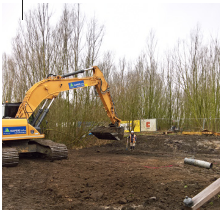
Foto 3: Een graafmachine schept de grond weg voor de creatie van een helofytenfilter.
