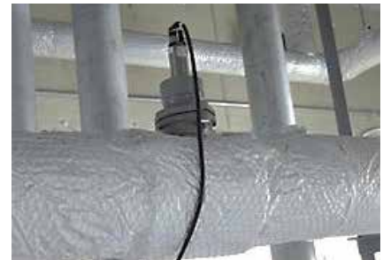
Figuur 3. Meetsensor om de vloeistofhoogte in de leiding te meten.
