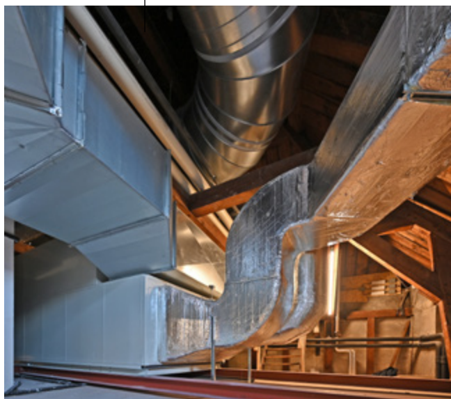
Foto 2: Het was puzzelen om de luchtbehandeling op zolder te installeren.
