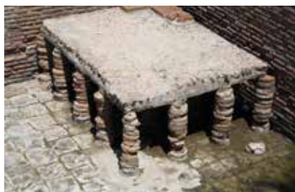
Afbeelding 1. Het Hypocaustum - Romans systeem van vloerverwarming
