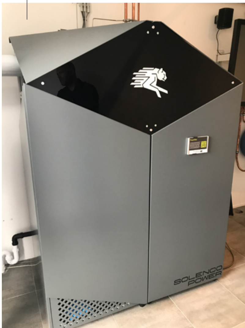
Foto 4: De Powerbox: een stoere mantel omhult een elektrolyser, de brandstofcel en de waterstofboiler.
