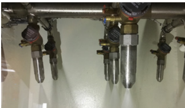
Foto 4: Een kozijn met raam als onderhoudsluik. Dat maakt het proces in de klimaatcascade zichtbaar voor iedere hotelgast die op de tiende verdieping de moeite neemt om even een hoekje om te lopen. Het proces transparant maken was een uitdrukkelijke wens van de opdrachtgever.
